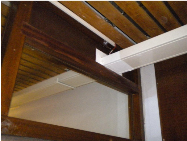
60 minuten brandwerende pui. Bovenlicht met triplexplaatje. Doorvoering voldoet, triplexplaatje niet.
