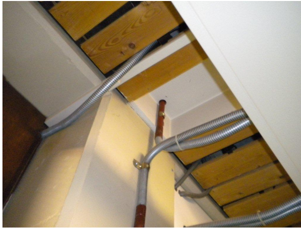
Doorvoeringen niet brandwerend uitgevoerd.
