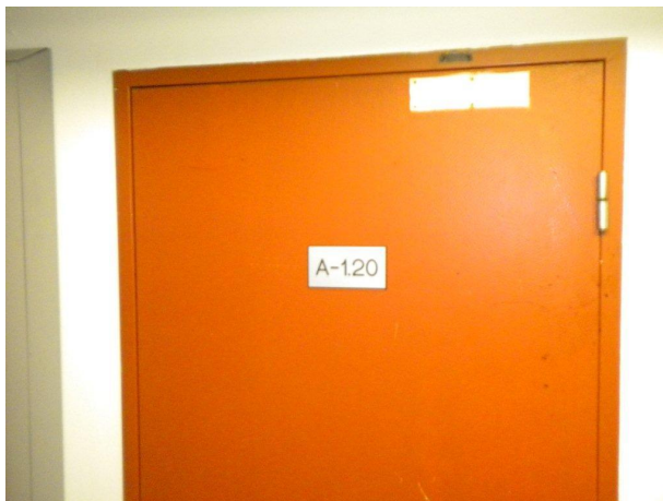
Brandwerende deur voorzien van deurdranger.
