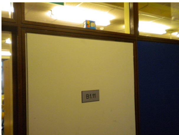
Brandwerende pui bij toegang trappenhuis. Het dichte (lichte) gedeelte bestaat uit een houten multiplex plaat oid. Nagegaan moet worden of deze constructie voldoet aan een brandwerendheid van 30 minuten.
