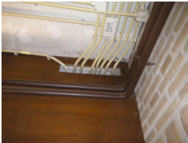
Doorvoering niet brandwerend uitgevoerd.
