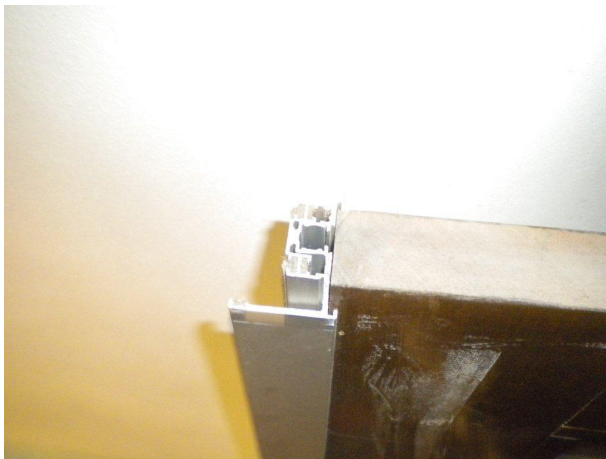
Brandwerende deur, 60 min. Deurnaald niet voorzien van Opschuimende strip.
