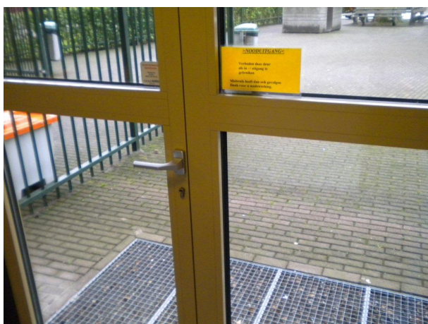
Nooduitgang niet voorzien van paniekbetlag of knopcilinder
